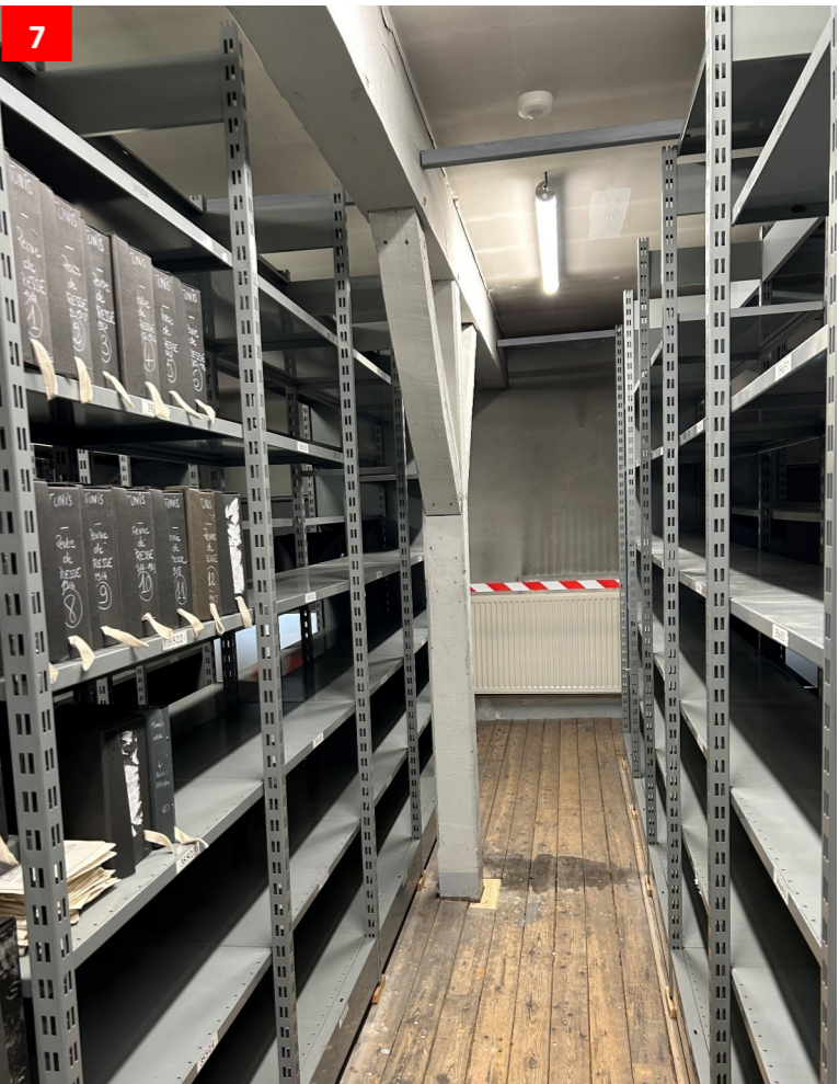
Les pieds d'étagères intérieures peuvent supporter des charges ponctuelles jusqu'à 500daN sur les pieds qui regroupent 4 étagères. Ces charges sont appliquées sans précaution particulière sur les lames de parquet qui ne font que 3cm d'épaisseur. Certaines cales sont installées afin de mettre à niveau les étagères car le sol n'est pas droit par endroit.
