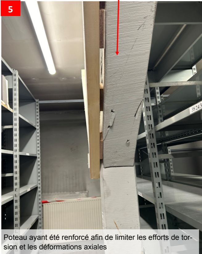
Poteau ayant été renforcés afin de limiter les efforts de torsion et les déformations axiales. Présence d'une importante gerce qui limite la capacité portante.
